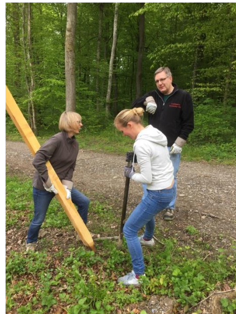
Der Wildschutzzaun wird mit Pfählen stabilisiert.
