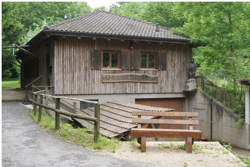
Forsthaus Kirschner (saniert und modernisiert im Frühjahr 2012)
